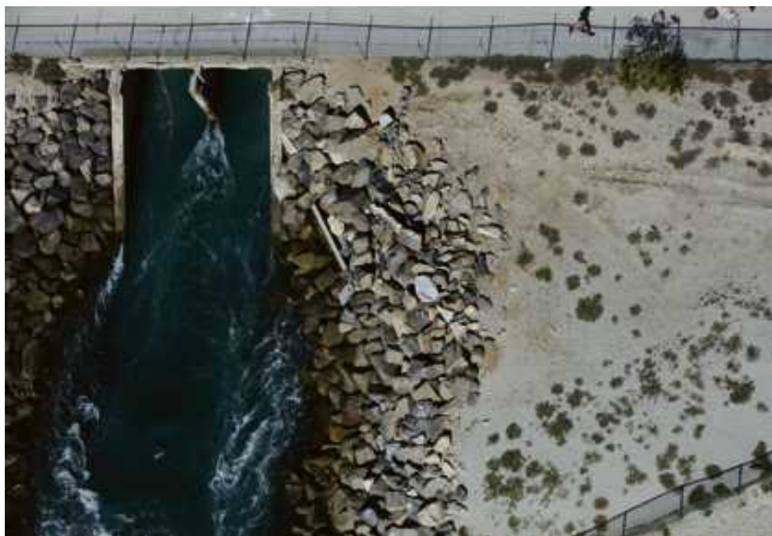
Vue aérienne de l'usine de dessalement de Carlsbad (Californie) en 2015. PHOTO PATRICK T. FALLON
