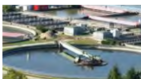
Traitement et Réutilisation des eaux usées
